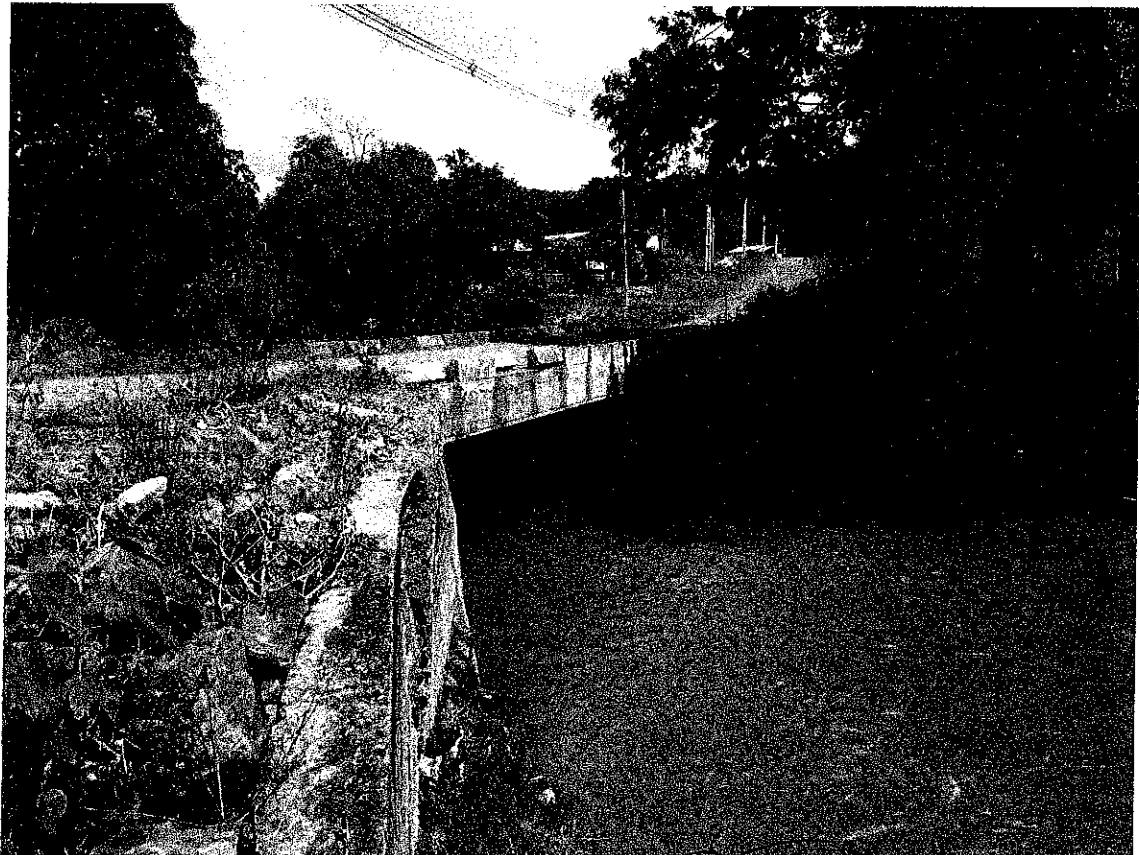
12.1.15 – Foto 15 – Ponte baixa
