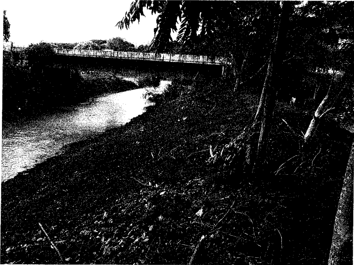
12.1.2 – foto 02 - Talude Inferior
