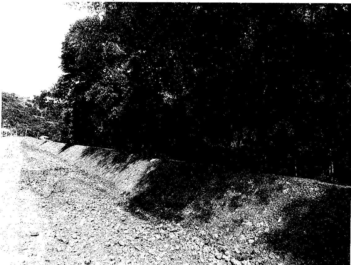
12.1.11 – Foto 11 – Talude Superior
